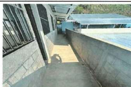
Foto 6: Cambio de piso ceramico o de granito (pasillo planta alta)
