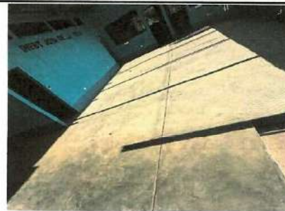
Foto 2: Cambio de piso ceramico o de granito (Patio)
