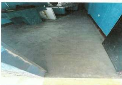
Foto 3: Cambio de piso ceramico o de granito (Cocina)
